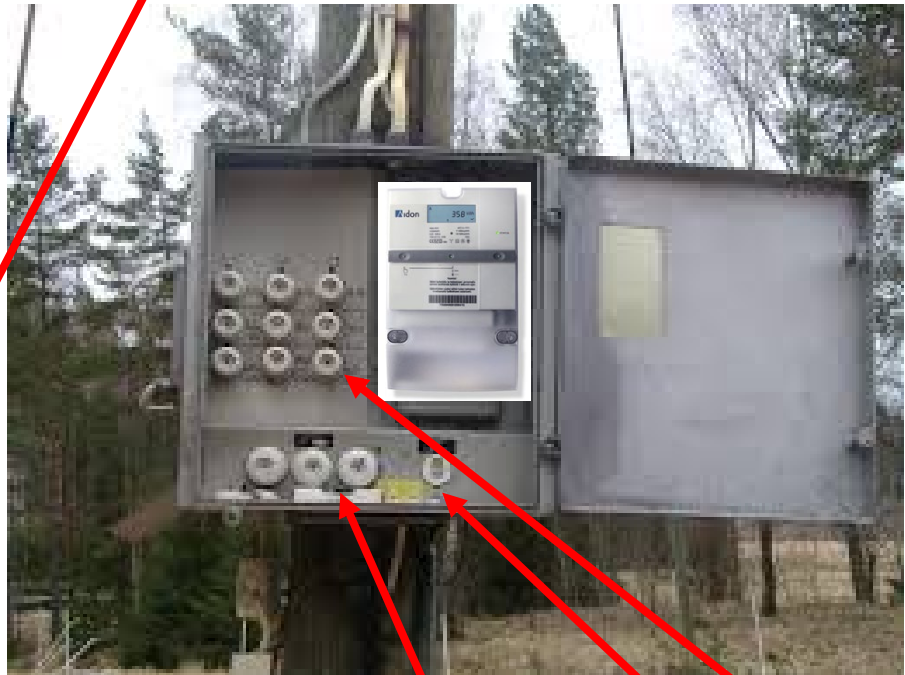
Ryhmäsulakkeita Pääkytkin
